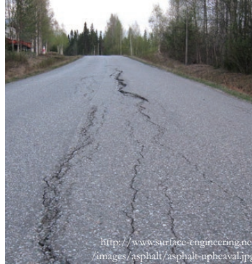
Longitudinal Cracks
